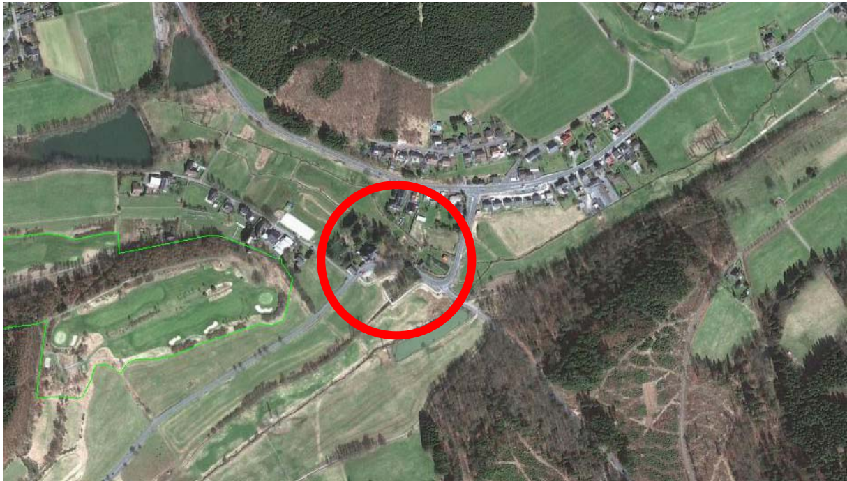
Abb. 1 Örtliche Lage von Schloss J. (Quelle: google.earth, Überfliegung am 4.6.2010)
